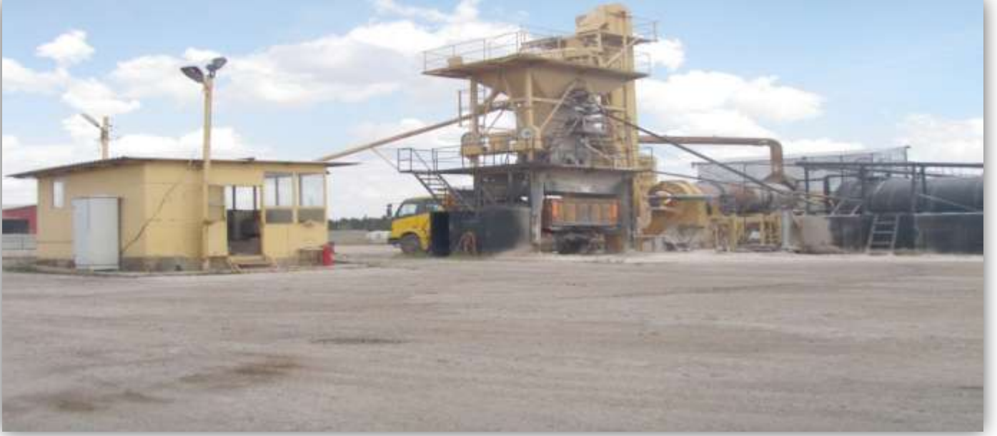
HAVSA ASFALT ŞANTİYESİ
